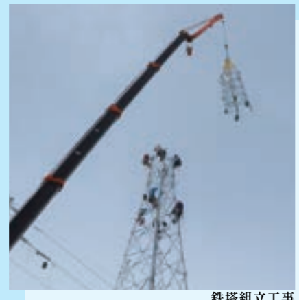
鉄塔組立工事
