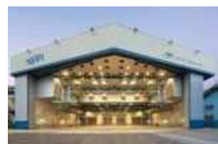
塗装ハンガー Paint hangar
