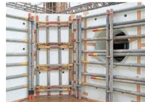
カタエもん 蓄熱槽断熱防水工法
