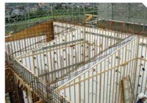
SMパネル 型枠兼用断熱材
