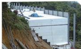
EDO-EPS工法 (エスレンブロック) 軽量盛土工法
