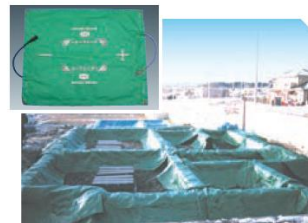
テクヒーター (シートタイプ) コンクリートの保温養生、凍結防止など
