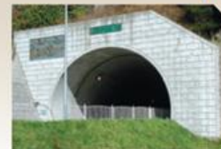
TYKフォーム コンクリート構造物に、天然石模様を 形成する化粧型枠
