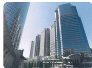
品川駅東口地区 地域冷暖房プラント
