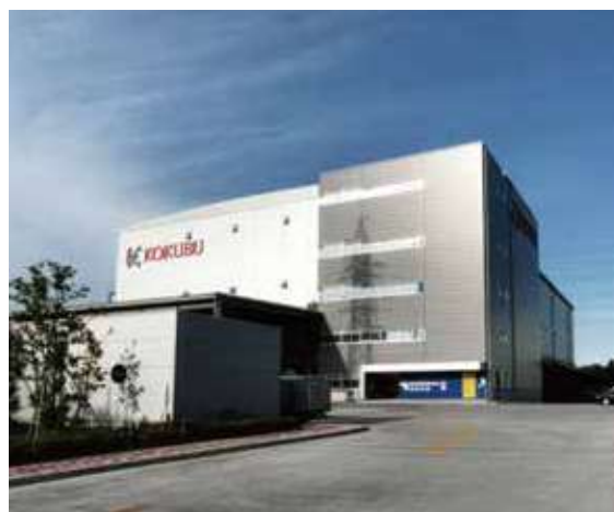
八潮市 八潮区分倉庫
