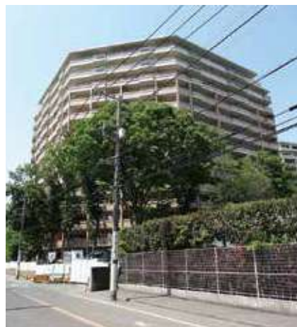
世田谷区 桜上水マンション
