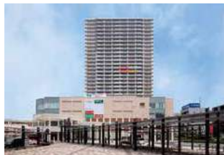
越谷市 越谷駅東口再開発
