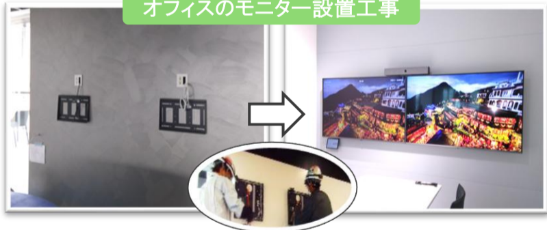
オフィスのモニター設置工事
