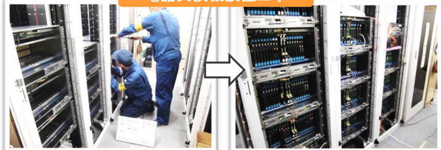
電話交換機設置工事
