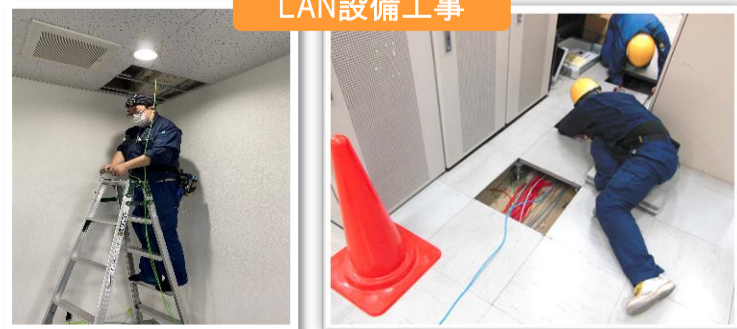
LAN設備工事
