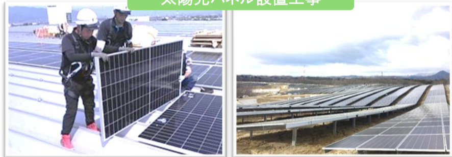
太陽光パネル設置工事
