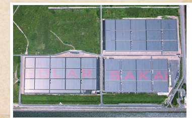
関西電力 堺太陽光発電所
