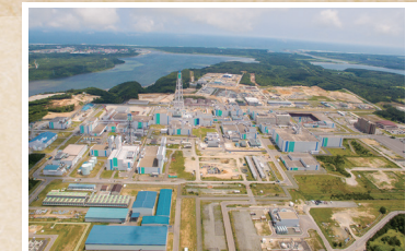
日本原燃 六ヶ所 再処理工場
