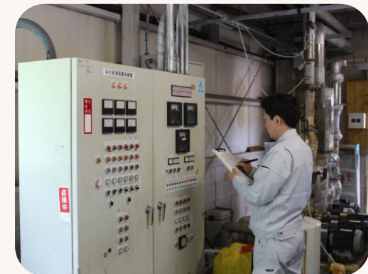
浄水設備の点検
