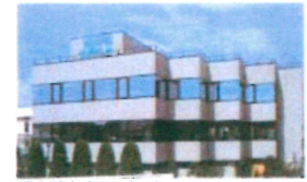
厚生棟(バルハウス)
