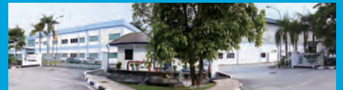
マレーシア工場
