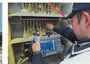
インターネット用光回線 心線接続工事
