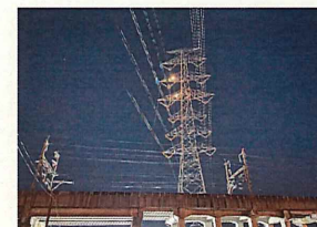
新仙台火力A線他電線張替32工事 (2工区)
