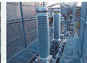
地中送電線路 分岐設備新設工事 施工場所：東京都 発注者：東日本旅客鉄道株式会社
