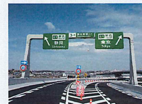
首都高速道路 横浜環状北西線標識設置工事 施工場所：神奈川県 発注者：首都高速道路株式会社
