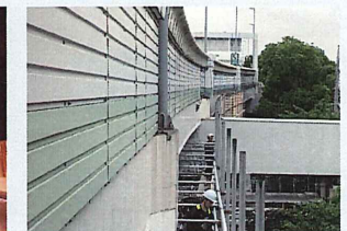
首都高速道路 狩場線上部工補強工事(恒久足場) 施工場所：神奈川県 発注者：首都高速道路株式会社
