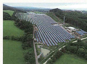
紋別市弘道 太陽光発電所建設工事 施工場所：北海道 発注者：合同会社SS紋別
