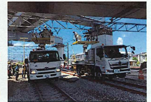
上沼垂信号場 高架化工事 施工場所: 新潟県 発注者: 東日本旅客鉄道株式会社
