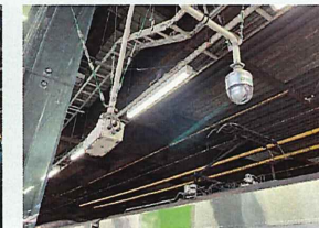
浜松町駅 通信設備工事 施工場所：東京駅 発注者：東日本旅客鉄道株式会社
