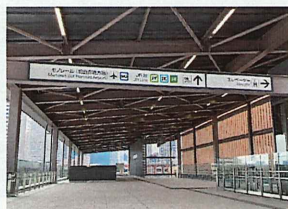
浜松町駅 照明設備新設工事 施工場所：東京都 発注者：東日本旅客鉄道株式会社
