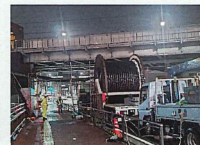
特高ケーブル 延線(ドラム)工事 施工場所：神奈川県 発注者：東日本旅客鉄道株式会社
