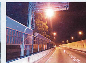
第二神明道路 月見山高架橋遮音壁取替工事 施工場所：兵庫県 発注者：西日本高速道路株式会社
