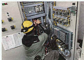
埼玉新都市交通 大成き電変電所き電設備取替工事 施工場所：埼玉県 発注者：東日本旅客鉄道株式会社
