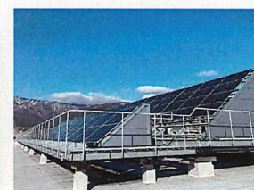
セイコーエプソン株式会社伊那事業所 太陽光設備設置工事 施工場所：長野県 発注者：セイコーエプソン株式会社
