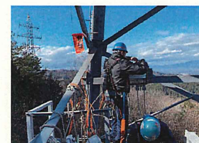
A局-B局間中継線構築工事 (OPGWルート)
