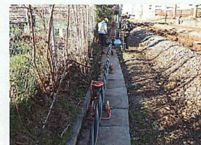
特高ケーブル 延線(コロ)工事 施工場所：神奈川県 発注者：東日本旅客鉄道株式会社
