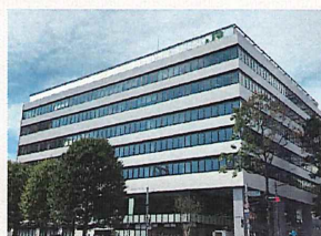
JR東日本仙台支社ビル 電気設備新設他工事 施工場所：宮城県 発注者：東日本旅客鉄道株式会社
