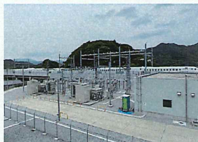
西九州新幹線 新設早変電所他変電設備新設工事 施工場所：長崎県 発注者：独立行政法人 鉄道建設・運輸施設整備支援機構
