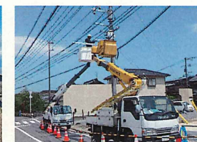
専用電話ケーブル 移設工事
