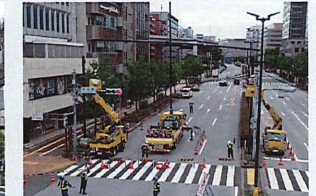
後楽橋交差点他 交通信号機改良工事 施工場所：東京都 発注者：警視庁
