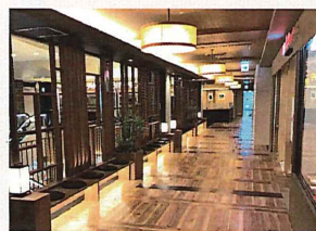
秋田ステーションビル トピコ&アルス3階改装工事 施工場所：秋田県 発注者：秋田ステーションビル株式会社
