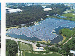
御天神辺池 ソーラー発電所建設工事 施工場所：香川県 発注者：合同会社香川水上ソーラー
