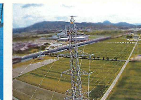
南京都新八幡線No.147-No.151 改良工事
