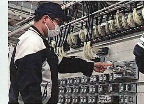
東北本線 連動取替信号設備改良工事 施工場所: 東京都 発注者: 東日本旅客鉄道株式会社
