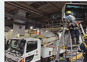
渋谷駅プロジェクト 通信設備工事 施工場所：東京都 発注者：東日本旅客鉄道株式会社
