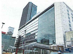
JR横浜タワー 新築電気設備工事 施工場所：神奈川県 発注者：東日本旅客鉄道株式会社
