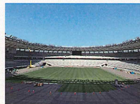
東京スタジアム(30) 改修電気設備工事 施工場所：東京都 発注者：東京都財務局
