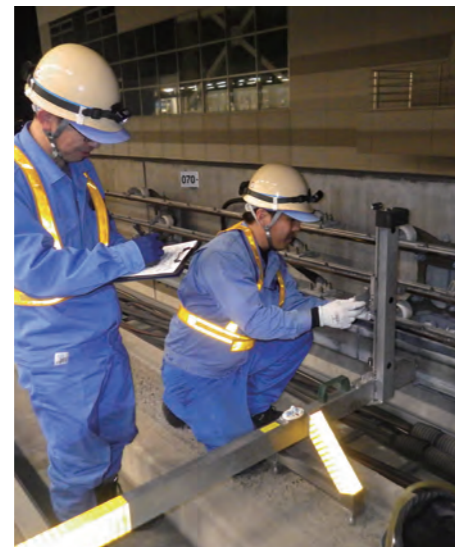
新交通軌道設備保守点検
