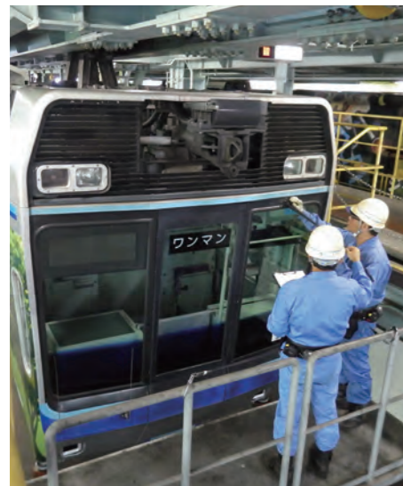
モノレール車両点検
