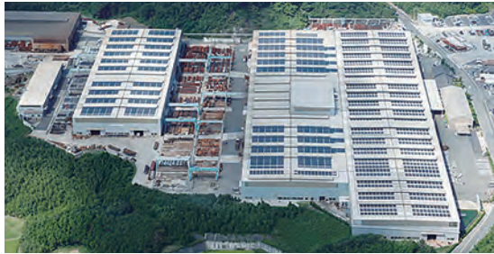
ヤマネ鉄工建設工場屋根 発電量：1.5MW
