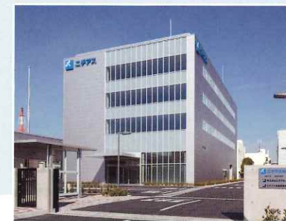
鶴見総合事務所棟 (神奈川県横浜市)
