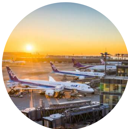
羽田空港跡地第1ゾーン整備事業
