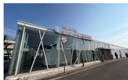
最寄駅（東山田駅）の外観
