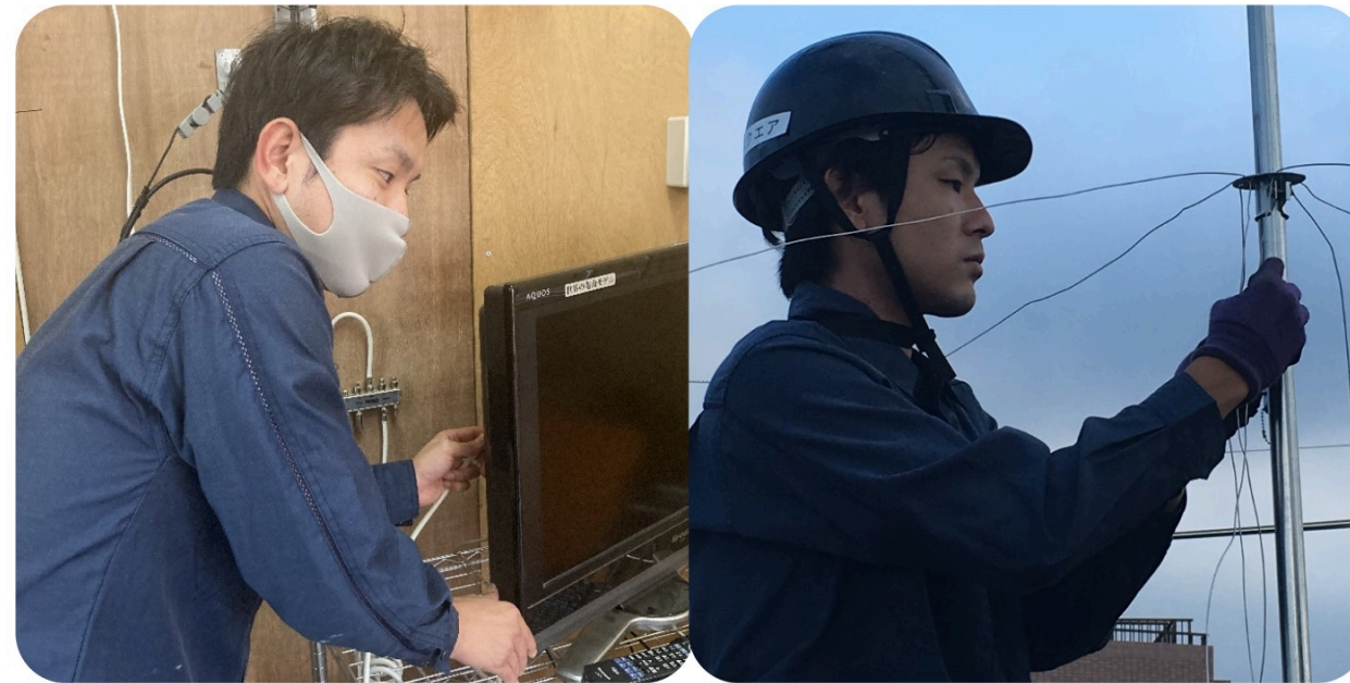
2.建物に通信機器の設置を行う
