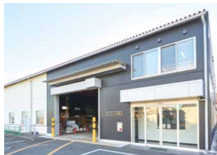
刈谷松坂事務所 (空調部) ■所在地: 刈谷市松坂町5-77
