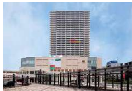
越谷市 越谷駅東口再開発
