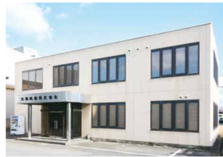
大府鋼材センター (鋼材部) ■所在地: 大府市横根町大猿尾125
