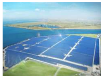
みやま合同発電所
