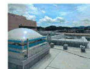
各種金物の設置
