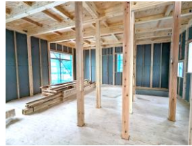
現場乗り込み前
