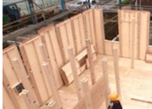
骨組みを組み立てる作業
