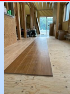
床材(フローリング)設置作業
