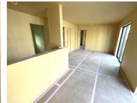
作業完了（木工事完了）
