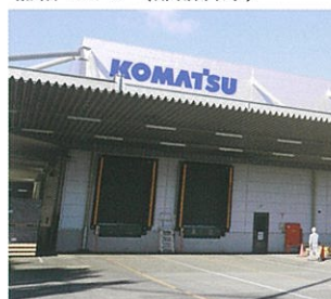
補給センタ（部品倉庫）
