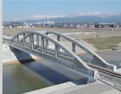
京ヶ瀬水原間新安野川橋りょう改築
