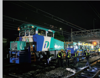
新潟駅連続立体交差事業
