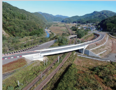
白沢・陣場間白沢こ線橋上部工新設
