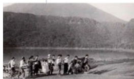
送電配送の様子
