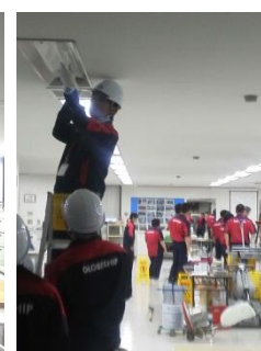
【照明設備(管球交換)】
