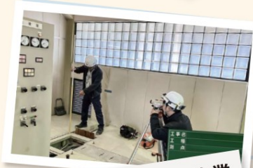
制御盤据付作業
