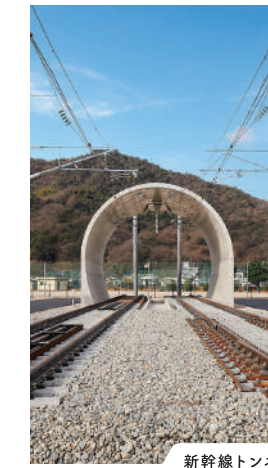
新幹線トンネル
