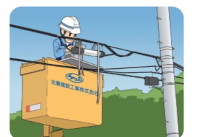
光ファイバー敷設
