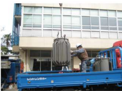
変圧器搬出作業
