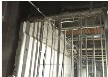
軽量間仕切り 配線状況
