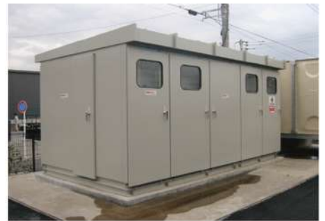
キュービクル設置
