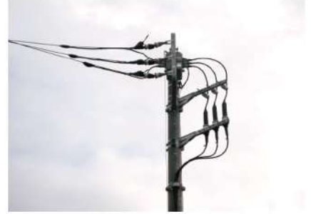
高圧受電設備装柱
