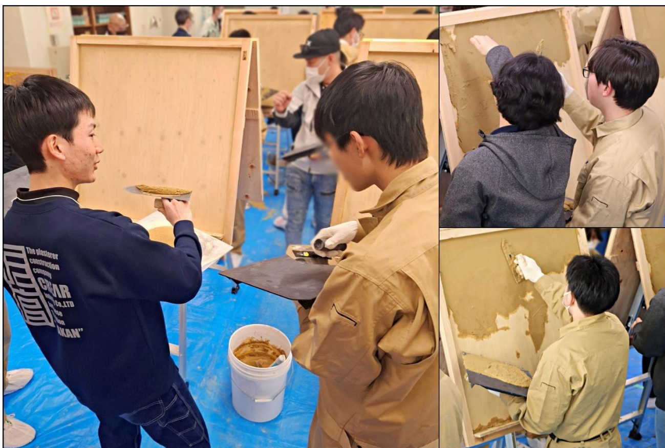
(写真左) 職人からの丁寧なレクチャー。鏝の使い方などを教わりながら 生徒は左官業への理解をより深めていった (写真右上) 体験を通して、徐々に打ち解けていった職人と生徒 (写真右下) 時間の経過を忘れて壁と向き合う生徒も
