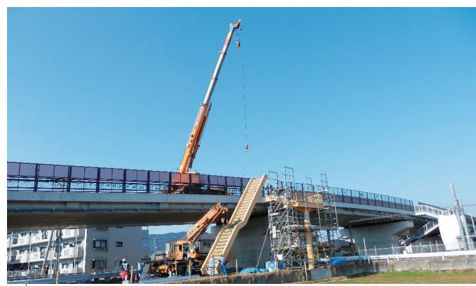
始良市の歩道橋設置状況です。歩道橋は当社工場で一貫して製作し、設置しました。
