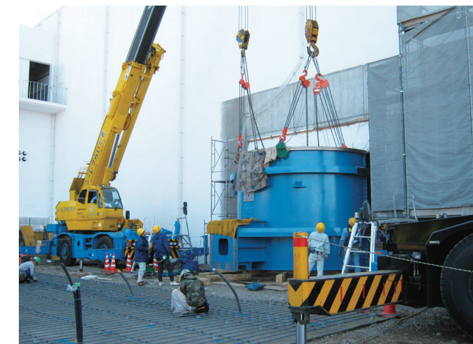
指宿市の陽子線がん治療センターでガン治療機の搬入据付を行いました。
