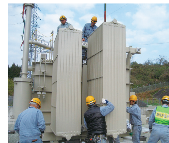
変電所における屋外変圧器の搬入据付状況で、クレーンを使用して据付を行います。クレーンが入らないなど作業が困難な現場も長年の経験と創意工夫で対応しています。
