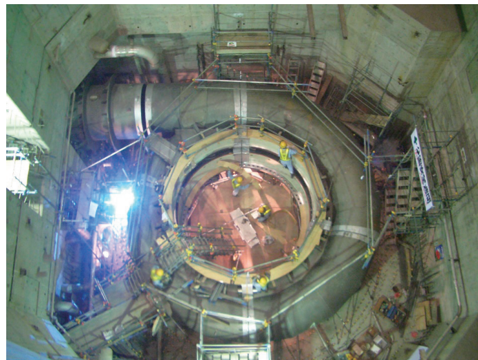
揚水発電所における水車ケーシングと呼ばれる機器の据付状況です。分割された状態で据付し、接続部を溶接して一体化します。
