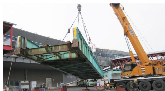
桜島フェリーターミナルの可動橋の修理・塗装後、据付を行いました。
