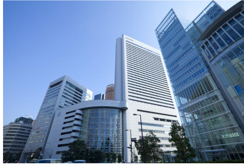
ヒルトンホテル大阪 大阪市北区 1986
