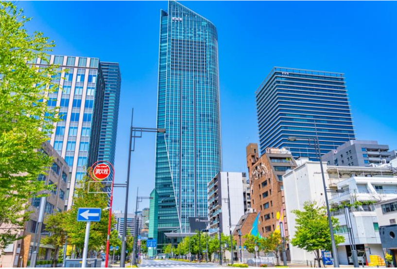
虎ノ門ヒルズビジネスタワー 東京都港区 2019
