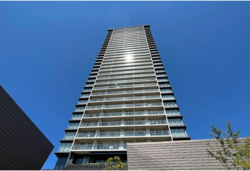
ブリリアタワー西新 福岡市早良区 2021
