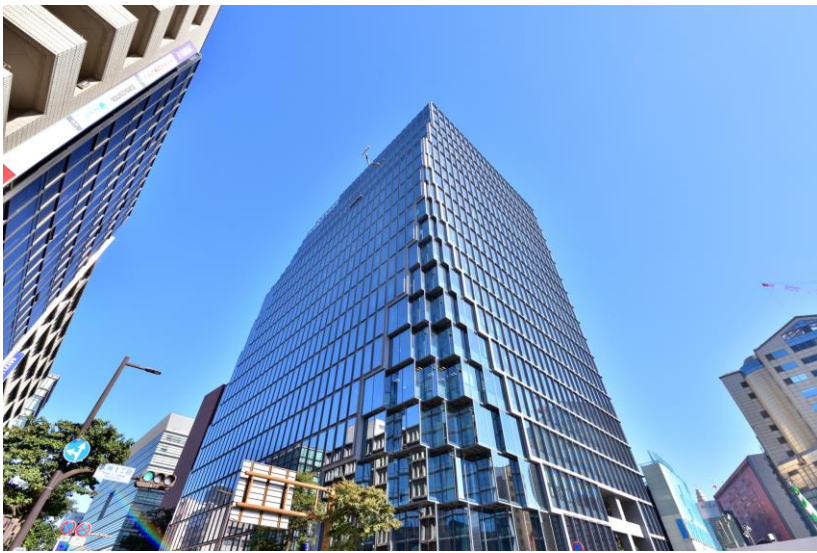
天神ビジネスセンター 福岡県福岡市 2021
