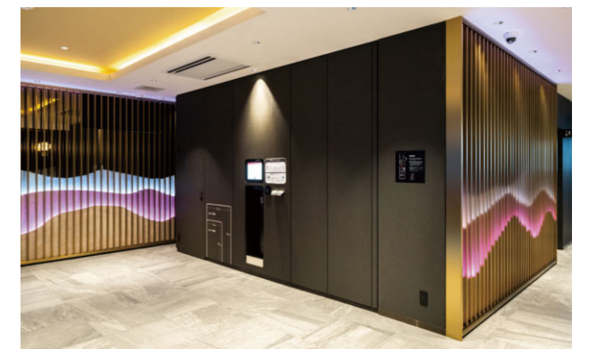
自動搬送型荷物保管システム
