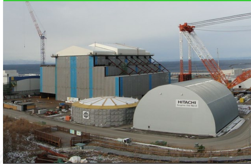
大間原子力発電所 (建設中)
