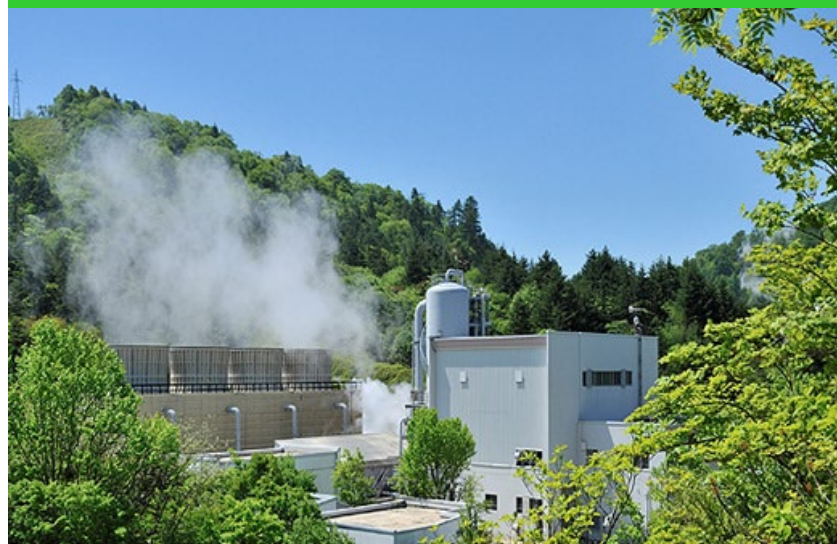
鬼首地熱発電所
