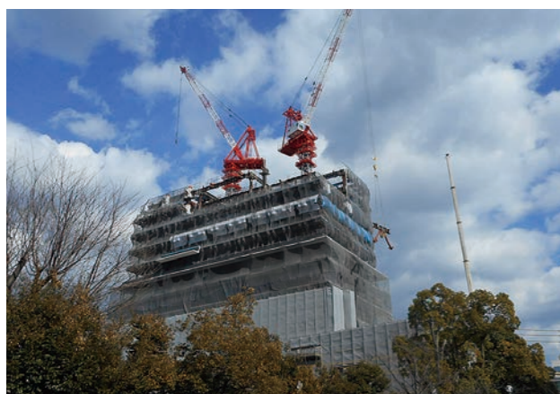
鉄骨建方・鉄塔建方・切梁工事
