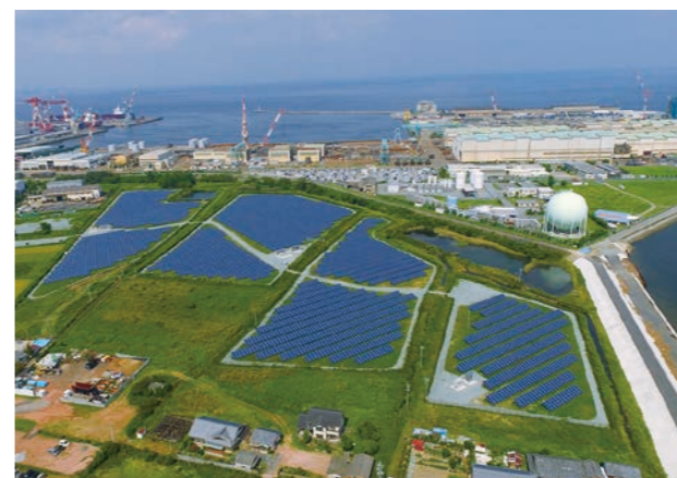
再生可能エネルギー太陽光発電設備設置工事
