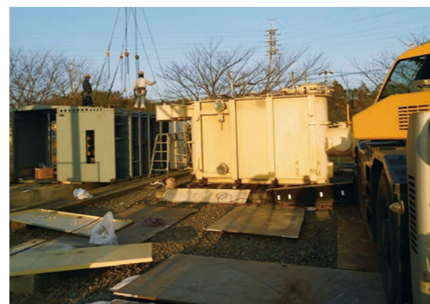
重量物移動据付工事
