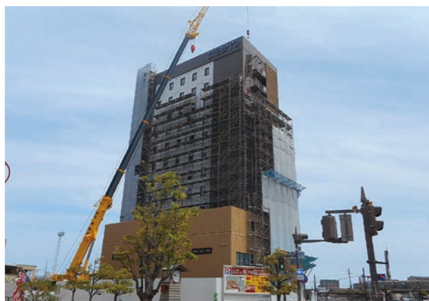
足場工事 (枠組・次世代・くさび式)
