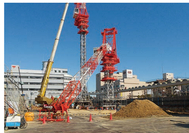
クレーン建方工事
