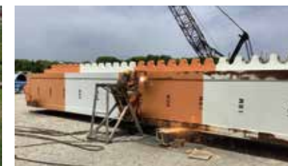
BHC2401 スパッド短縮工事
