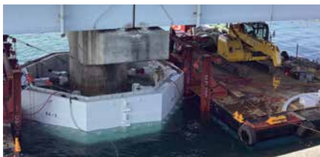
西浜名橋耐震補強工事 元請：五洋建設（株） 工種：仮設工（NDR工法：Neo-Dry Repair Method）
