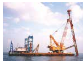
杭打船兼起重機船「CP-4501」 (五洋建設株式会社との共有船)
