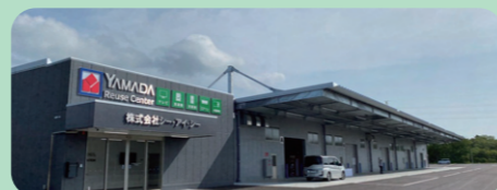
ヤマダ西日本リユースセンター山口工場 新工場
