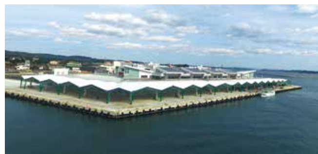
塩釜漁港魚市場棧橋外災害復旧工事 元請：日立造船株 工種：棧橋築造工
