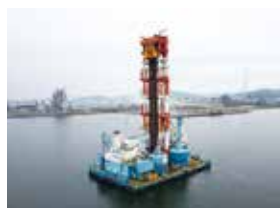
深層混合処理船「ポコム 2 号」 ※地盤改良面積 5.75㎡ (所有者：五洋建設株式会社)
