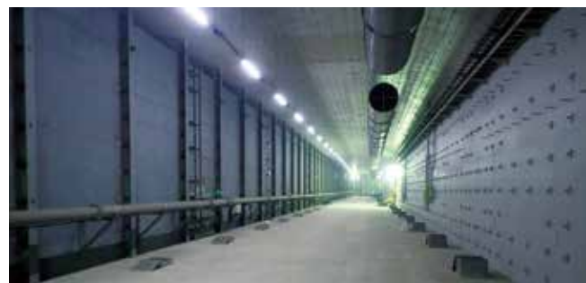
東京港臨港道路南北線沈埋函（4号函・5号函・6号函）製作・築造等工事 元請：五洋・東洋・新日鉄住金エンジニア特定建設工事共同企業体 工種：沈埋函製作工、艀装工
