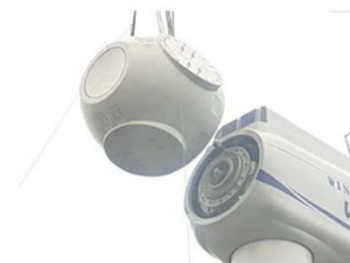
風車の羽を付けるハブを取付
