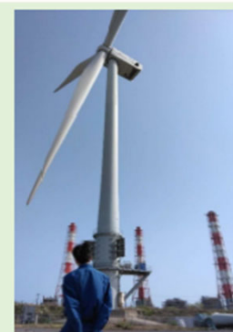
5MW東芝風力（茨城県神栖市）
