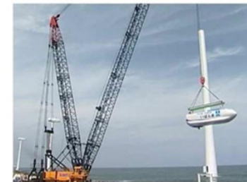
風車の羽を付けるハブを取付
