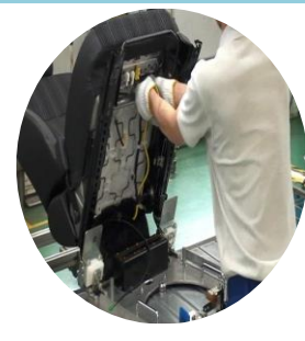
⑧ 配線作業の工程
