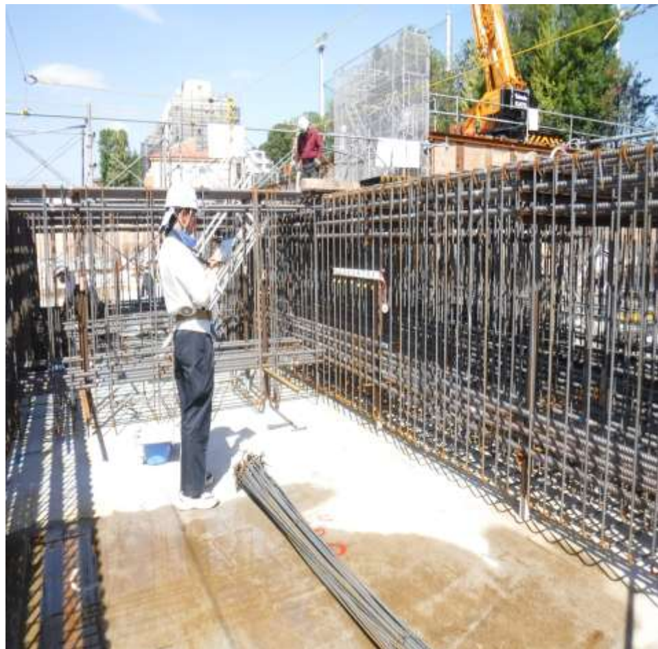
工事写真作業風景
