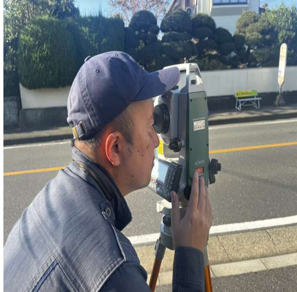
墨出し、測量作業風景
