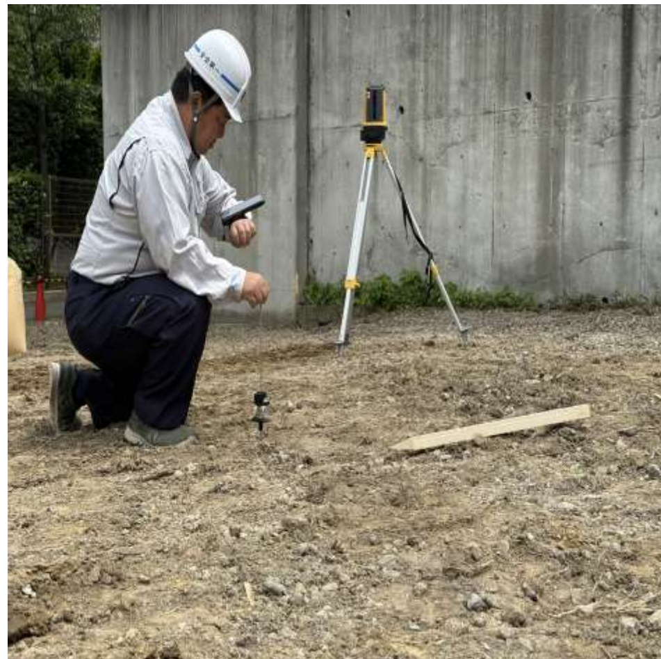
杭ナビ作業風景
