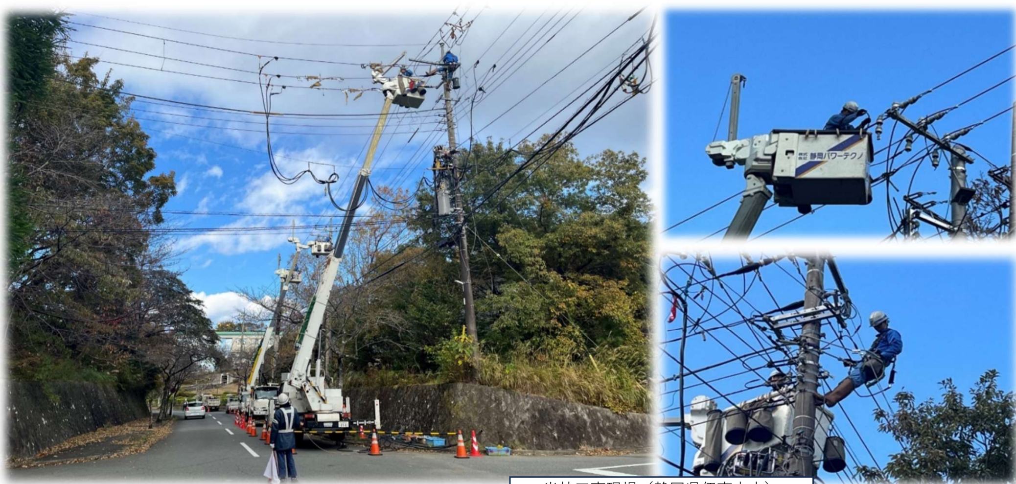
当社工事現場（静岡県伊東市内）
