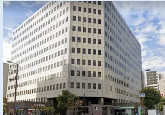
大阪支店（信濃橋三井ビル8階）
