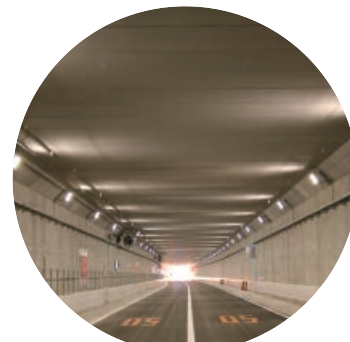
創成川通 トンネル換気設備新設
