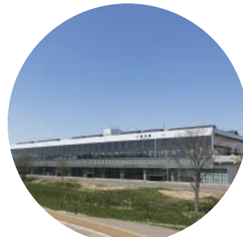
旭川駅 空調設備・昇降設備新設
