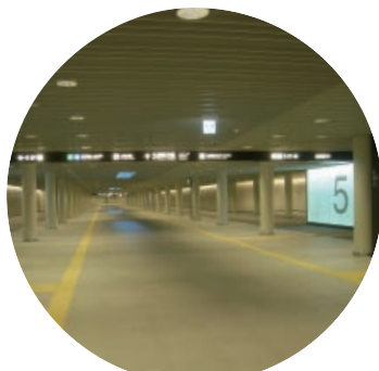
札幌駅前通地下歩行空間 冷暖房・衛生設備新設
