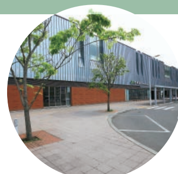
野幌駅 空調設備・昇降設備新設
