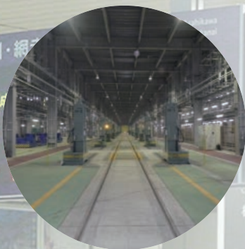
函館新幹線総合車両所 車両検修設備新設
