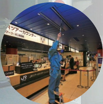
空調設備点検 (風量測定)
