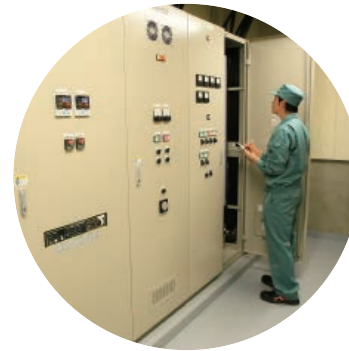
空調設備点検
