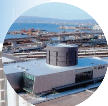
函館駅 空調設備・昇降設備新設
