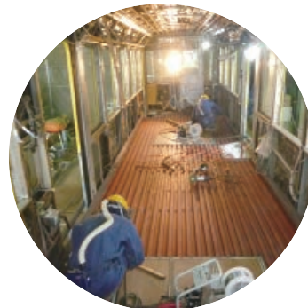
路面電車検修
