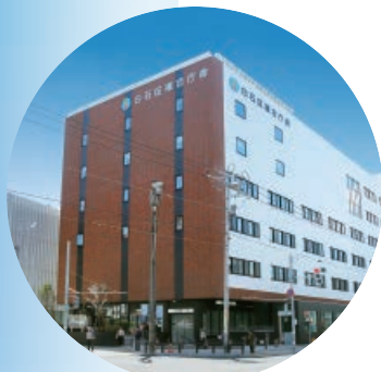
白石区複合庁舎 空調設備新設
