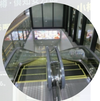
新函館北斗駅 エスカレーター新設
