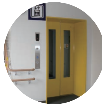
拓北駅 エレベーター新設
