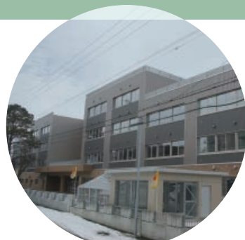
平岸西小学校 暖房衛生設備新設
