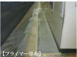
【プライマー塗布】
