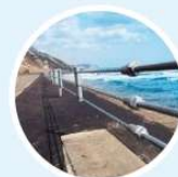
道路（ガードロープ）
