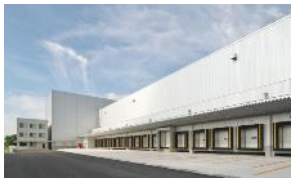
⑱九州 ロジスティクスセンター
