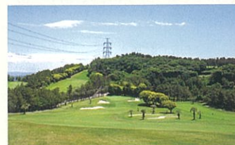
エメラルドコースのワングリーン化工事
